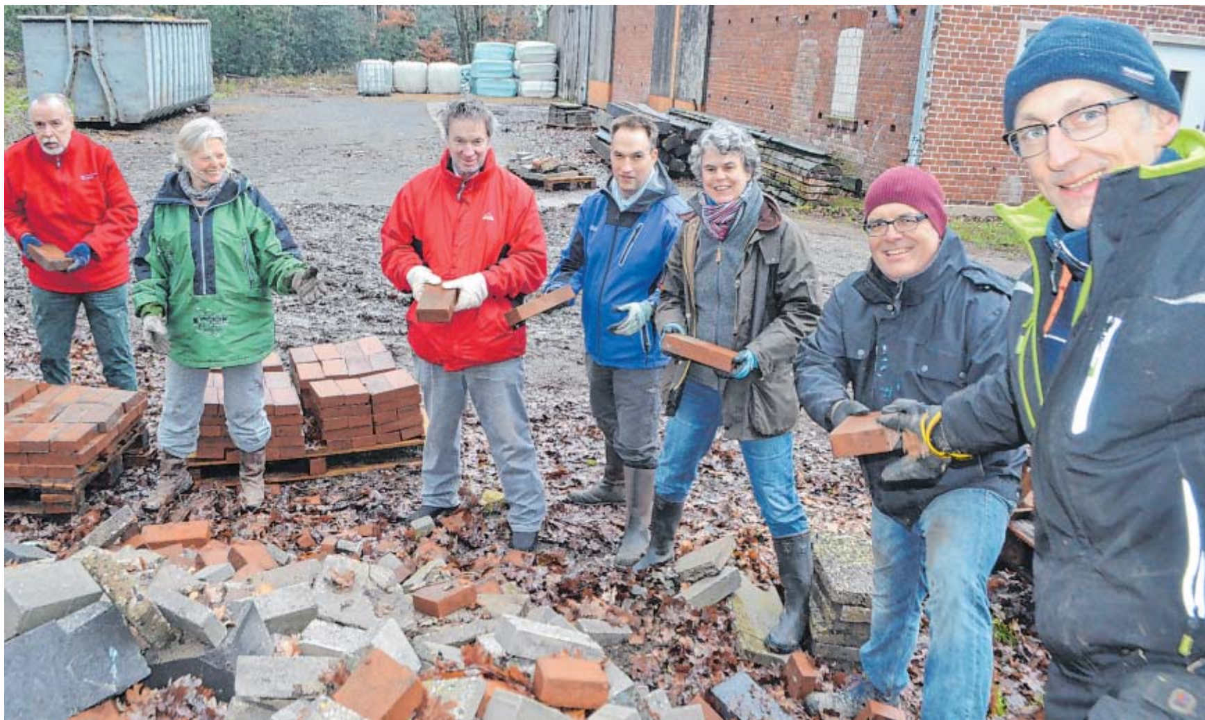
Steine sortieren: Beim ersten Arbeitseinsatz holen Wolfgang Heinrich, Gabriele Pollmann, Gerhard Haupt, Erik und Ute Twelker, Dietmar Althaus und Uli Gödde (v. l.) die gespendeten Steine vom großen Haufen und stapeln sie auf Paletten, damit die Gartenbauer im Sommer gut pflastern können.
